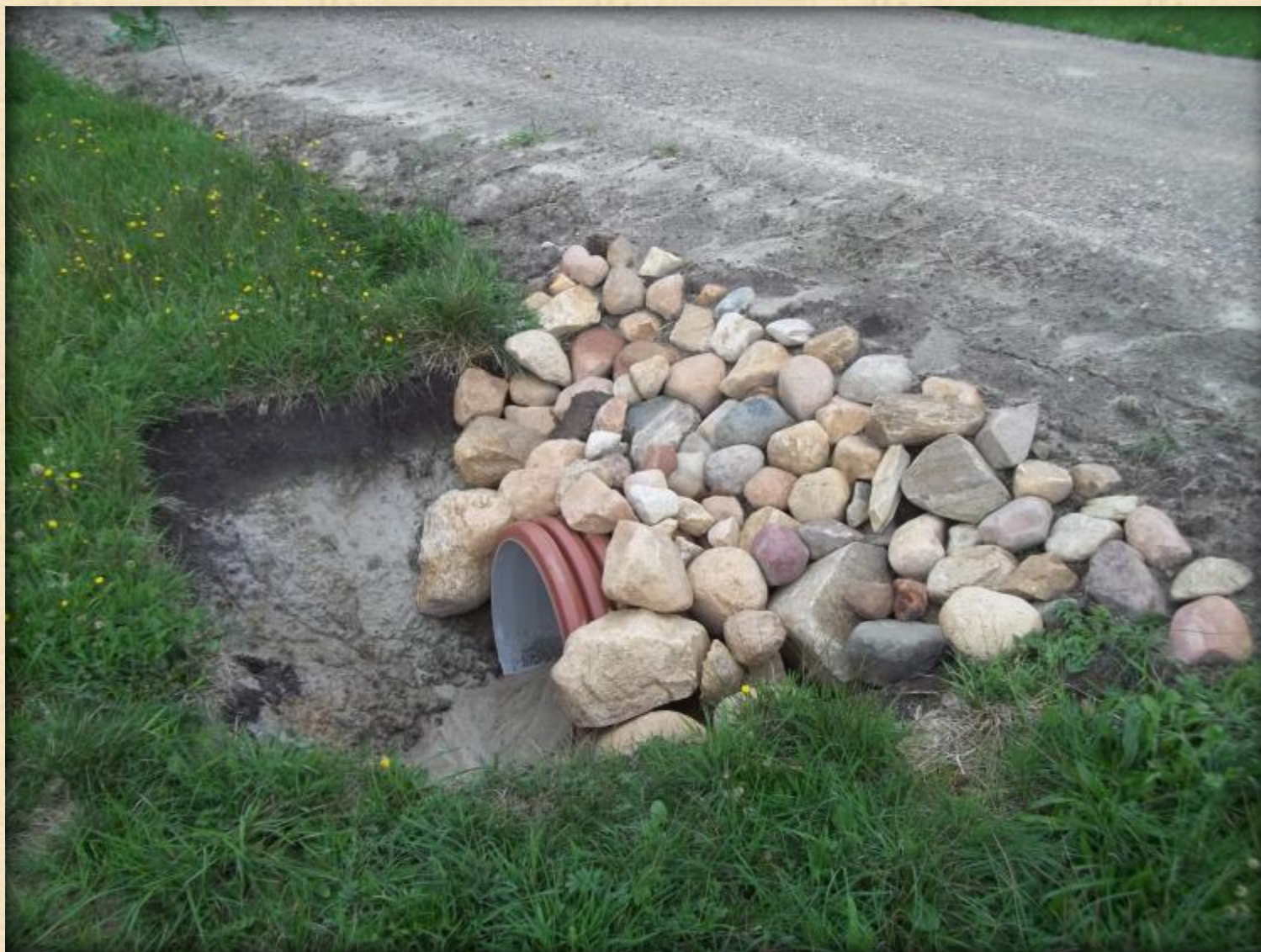
Przepust na drodze nr 12a
