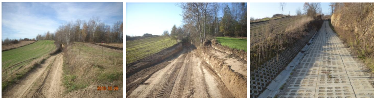
Ilustracja 12. Rozbudowa drogi rolniczej w ramach zagospodarowania poscaleniowego w sołectwie Latczyn (woj. lubelskie) (fot. R. Rybicki)
