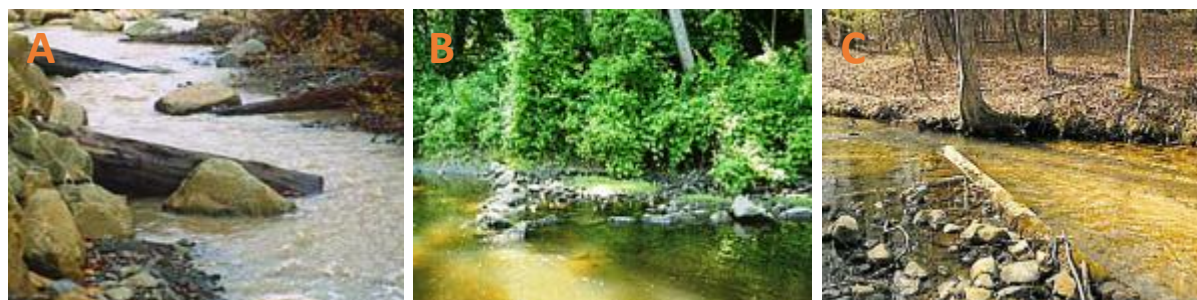
Ilustracja 18. Deflektory: A – w formie pali i głązów, B – kamienny, C – drewniany
