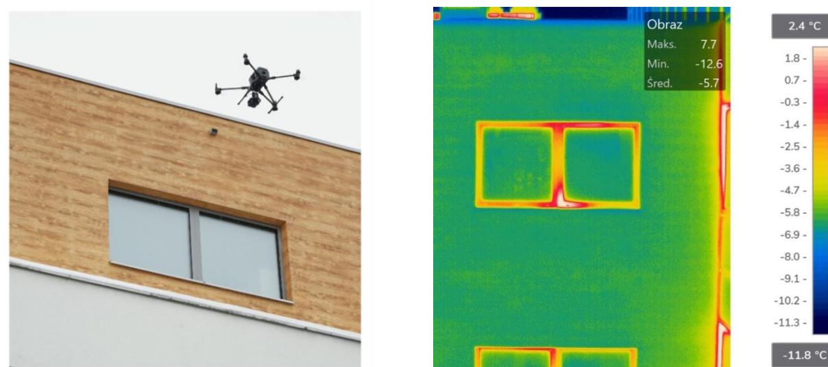
Ryc. 34. Inspekcja termowizyjna budynku
